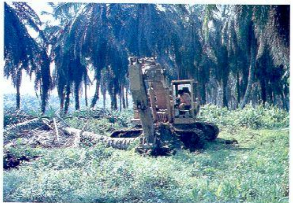
Kerja memumbang dan meracik batang sawit menggunakan hydraulic boom excavator
