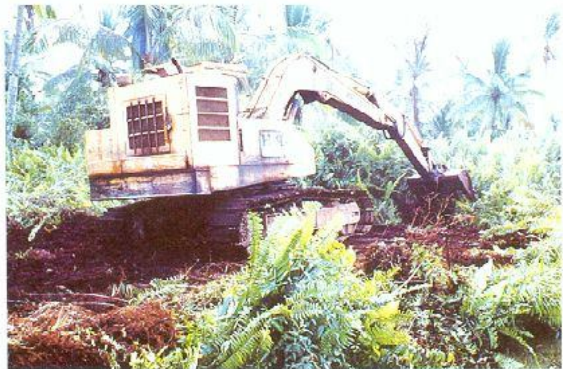
Kerja memampat dengan menggunakan jentera excavator.
