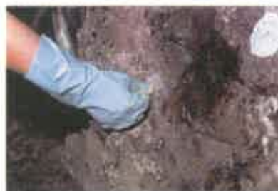
图9c. 以粘土将洞孔封密。
