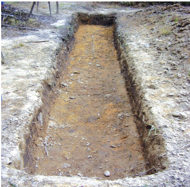
Rajah 5. Longkang mendakan (silt pits) yang dibina di ladang bagi memerangkap air dan sedimen tanah.
