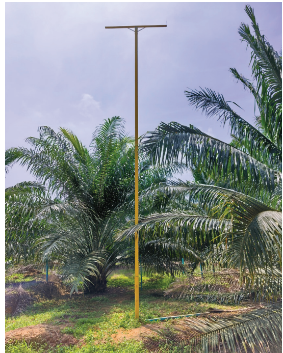
Rajah 3. Pemasangan tiang berburu di atas paras kanopi sawit.
