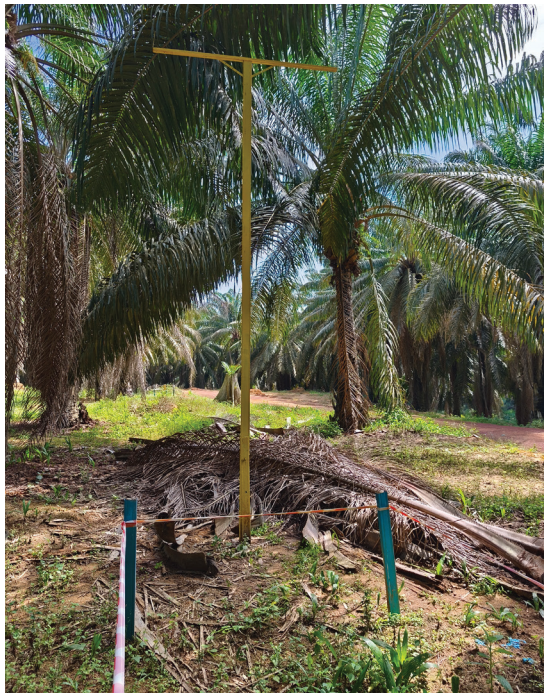
Rajah 2. Pemasangan tiang berburu di bawah paras kanopi sawit.
